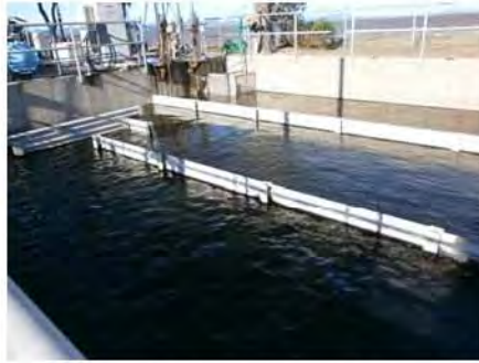
fiberglass baffle walls 3.jpg
