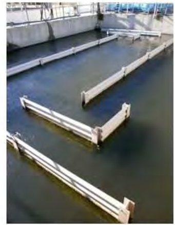
fiberglass baffle walls 4.jpg
