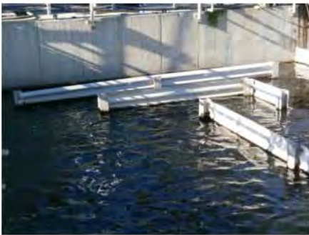
fiberglass baffle walls 1.jpg
